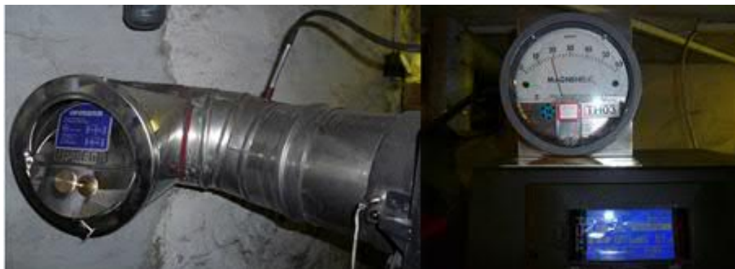
Obr. Měření komínového tahu
